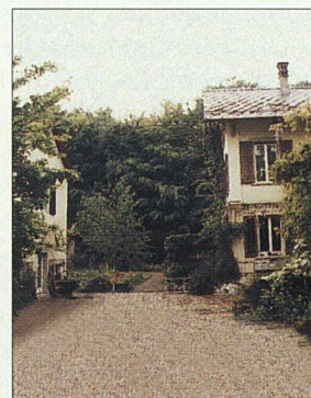
Idyllischer Kopfsteinplatz mit ehemaligen Stellwärtershäuschen (l.) und Direktorenvilla (r.).
