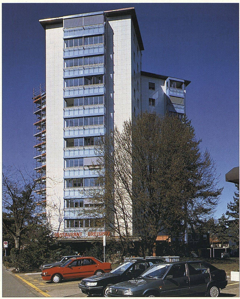
Im neuen Kleid: Die wesentlich vergrösserten und komplett verglasten Balkone prägen das Erscheinungsbild des renovierten Hochhauses Dreispitz an der Saatlenstrasse 110 in Zürich-Schwamendingen.
