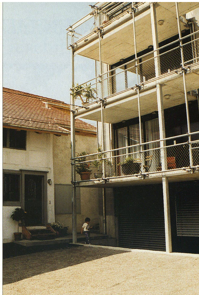
Licht- und Schattenseiten: Nicht alle Hönegger/innen lieben den Neubau...
