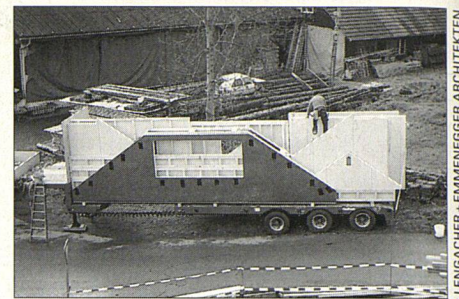
Die fixfertigen Elemente werden angeliefert...
