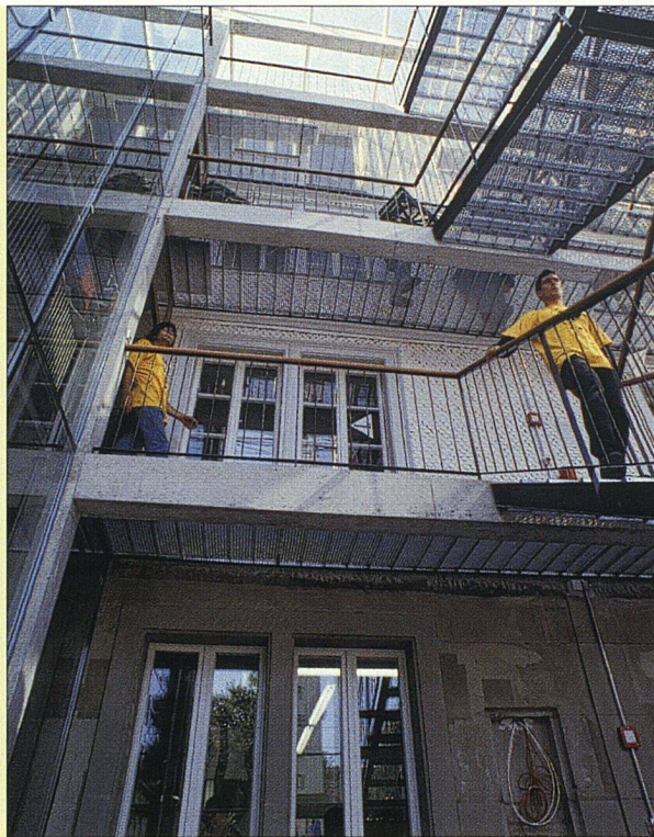
Lichtdurchflutet präsentiert sich das Treppenhaus. Auf Transparenz legten die Architekten bei der Renovation des Hauses grossen Wert.
