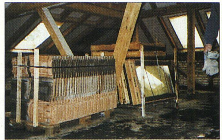
Die Bauteile des ganzen Dachstocks werden abgebaut und finden anderenorts wieder eine neue Verwendung.
