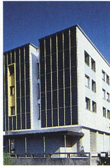
Immer öfter werden Solaranlagen als Fassadenelemente eingesetzt.
