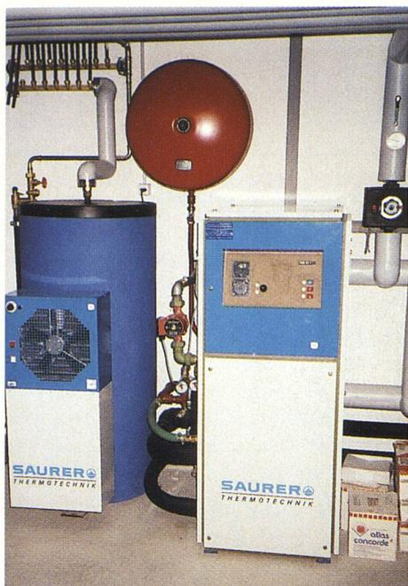
Ebenso zentral wie die Frage nach der Art der Heizung ist jene der Dimensionierung. Die Leistung eines Wärmeerzeugers richtet sich nach dem Heizwärmebedarf der Bauten, und dieser ist ganz wesentlich von der Qualität der Gebäudehülle abhängig.
