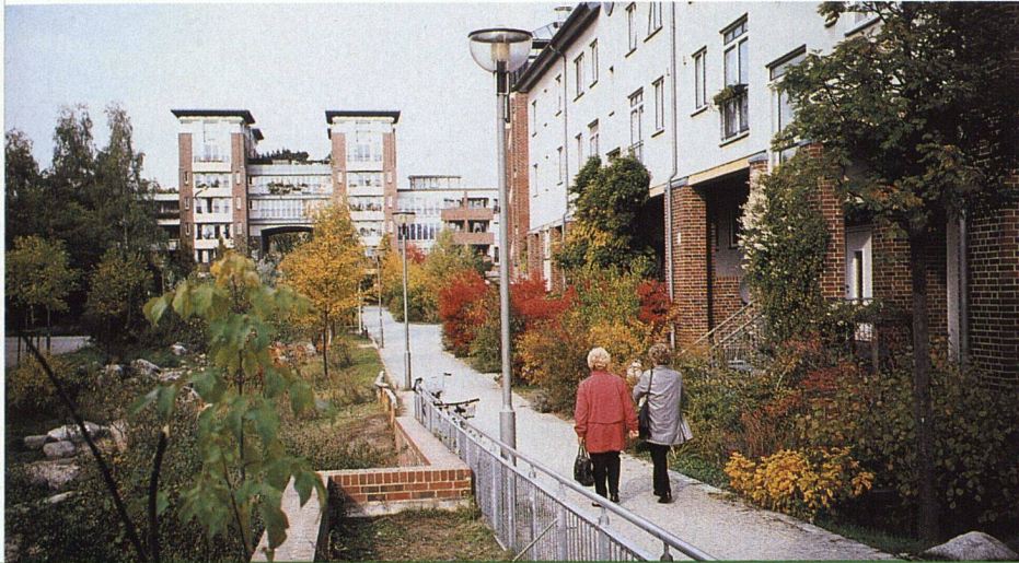
Die «Autofreie Ökosiedlung» Berlin-Zehlendorf besitzt allerdings eine Tiefgarage und das Parkieren am Rand des Viertels ist erlaubt.
