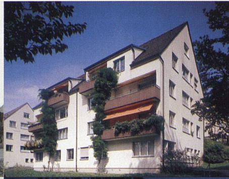
In den 70er-Jahren wurde die Überbauung im Bereich der Gebäudehülle saniert und dadurch optisch stark verändert.
