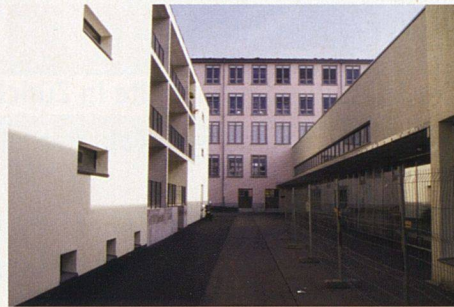
Das attraktive Areal ist dicht bebaut: Rechts neben der Neubausiedlung die Schule, im Hintergrund das letzte erhaltene Fabrikgebäude.
