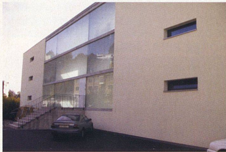
Eine Glaswand schützt den Eingangsbereich gegen den Strassenlärm.
