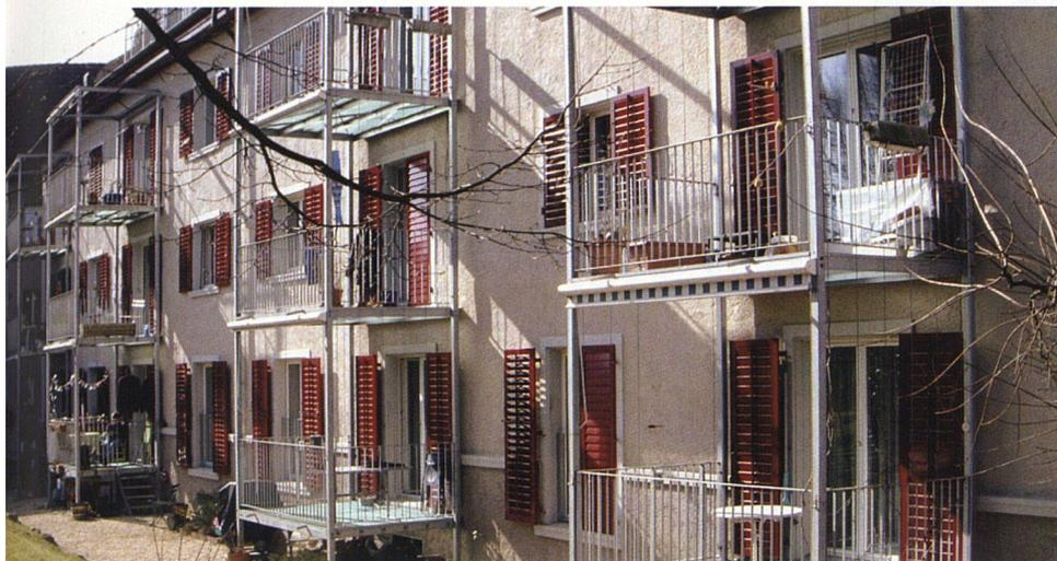
Auf eine Turmlösung setzt die Baugenossenschaft Zürich-Oberstrass: Dank der als Roste ausgebildeten Brüstungen, der Bodenplatten aus Milchglas und der seitlichen Stahlseile, wo dereinst Kletterpflanzen wachsen werden, kommen die neuen Konstruktionen allerdings filigran und durchlässig daher.
