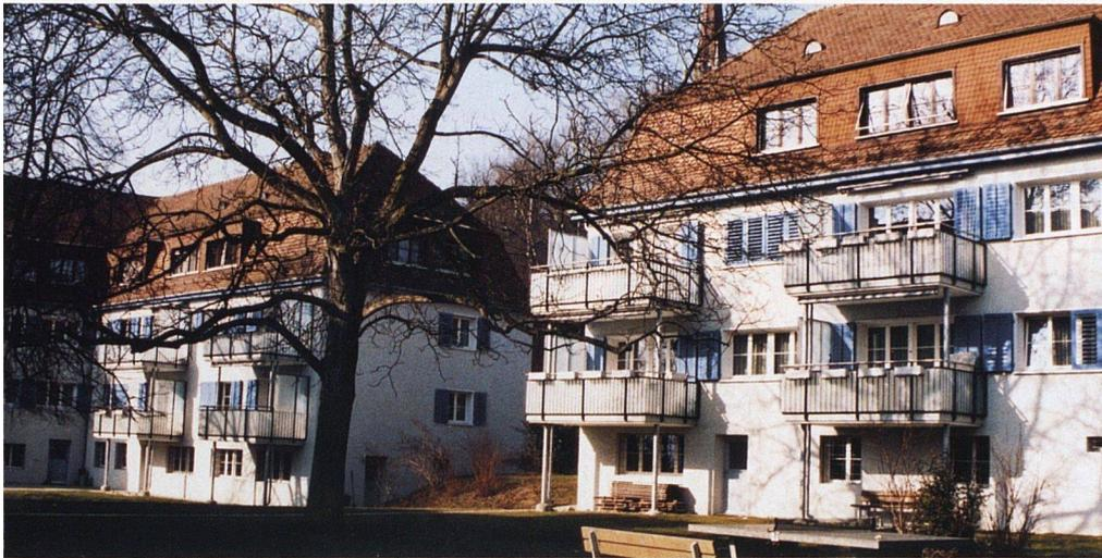
Denkmalpflegerisch gelungene Lösung bei den neuen Balkonen der Siedlung Geibel in Zürich-Wipkingen (Baugenossenschaft Waidberg): In einer statischen Mischkonstruktion sind sie an den Häusern aufgehängt und zusätzlich mit schlanken Pfeilern abgestützt
