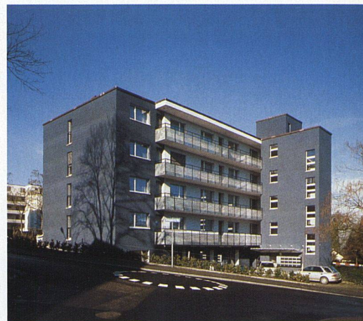
Die Bauten an der Friesenberghalde stammen vom bekannten Architekten Ernst Gisel. Er arbeitete bei der Farbgebung und vielen weiteren Details der Sanierung mit.
