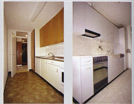
Küche vorher und nachher. Die Arbeitsfläche besteht aus Granit.
