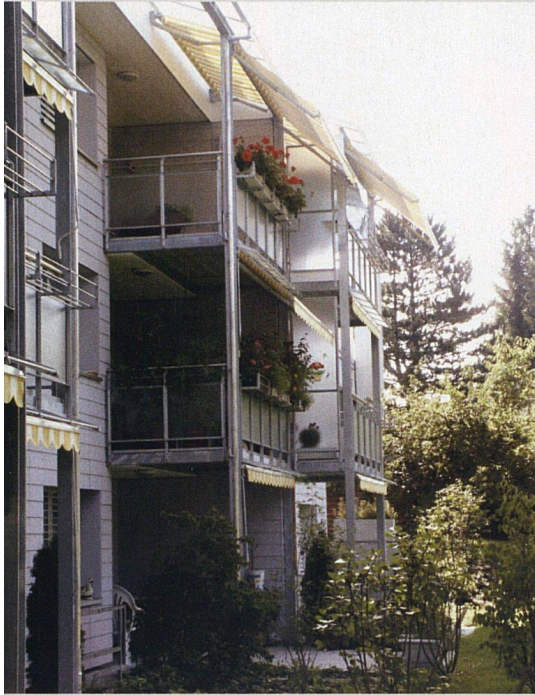
Um den Lichtverlust durch die grössere Balkonfläche gering zu halten, setzte man Glaselemente ein.
