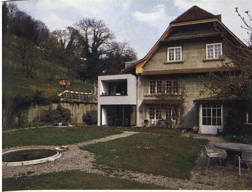
Blick vom Garten, links ist der neue Anbau ersichtlich. Er enthält Lift, Küchen und Nasszellen.
