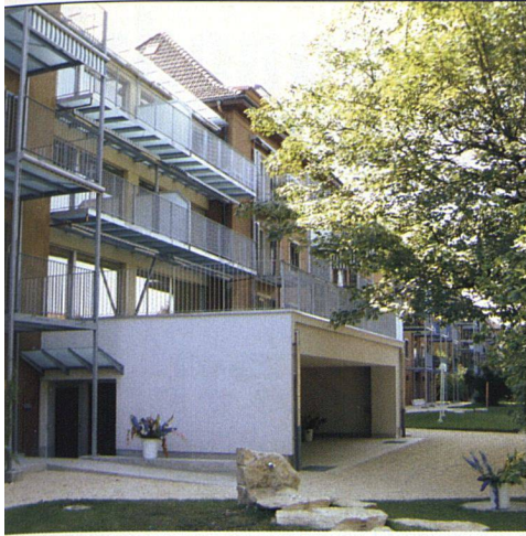
Sicht von der Hofseite; im Parterre wird die Kinderkrippe «Murmel» einziehen. Die dortige Fläche kann jedoch ohne grossen Aufwand wieder in zwei Wohnungen verwandelt werden.
