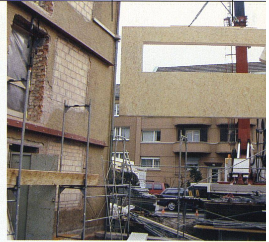
Dank vorfabrizierter Holzelemente konnte der Bau im Wesentlichen in einem Tag erstellt werden.
