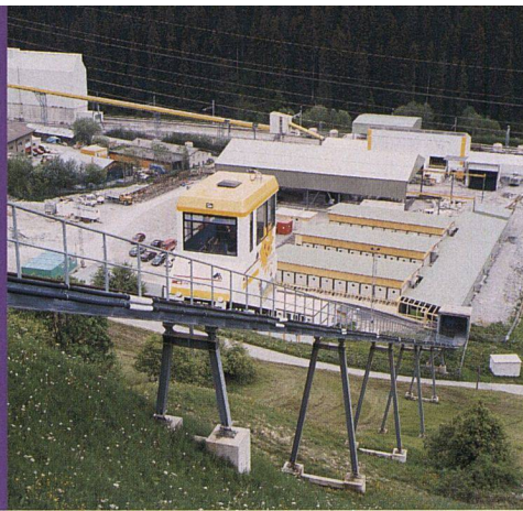
Die Neat-Baustelle des Zwischenangriffs in Sedrun. Mit diesem Aufzug fahren die Mineure zur Arbeit, er verbindet das Containerdorf mit der Baustelle.
