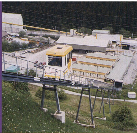
Die Neat-Baustelle des Zwischenangriffs in Sedrun. Mit diesem Aufzug fahren die Mineure zur Arbeit, er verbindet das Containerdorf mit der Baustelle.
