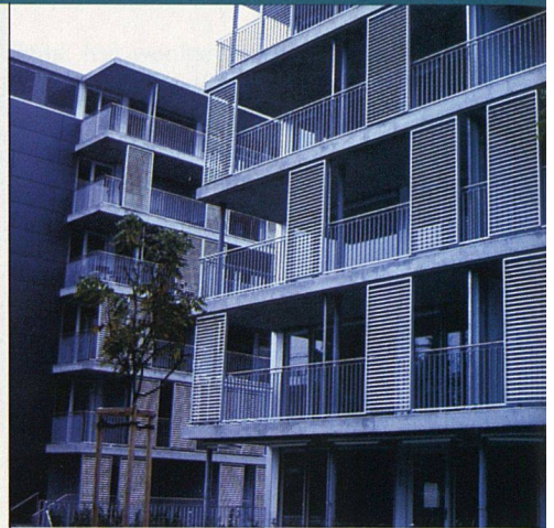
Ein Beispiel für innovative Fassadengestaltung: Die Wohnüberbauung Dennlerstrasse mit den Schiebe-Lamellen von Hammer Metallbau.
