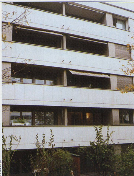
Früherer Zustand: Anlässlich einer Fassadensanierung waren die Balkonbrüstungen geschlossen worden, was sich ungünstig auf die Lichtverhältnisse in den Wohnzimmern auswirkte.
