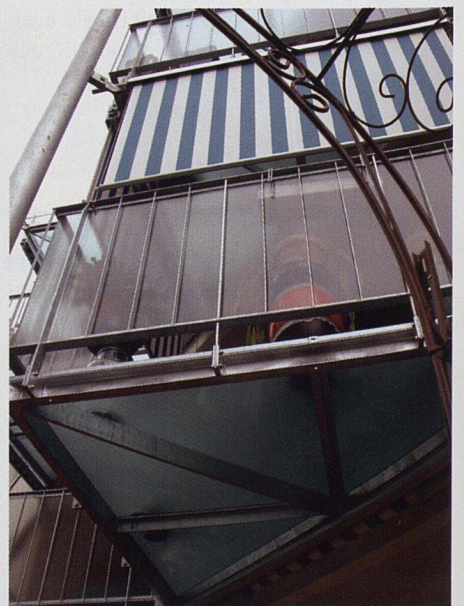
Glas kam auch bei den Balkonböden zum Einsatz.
