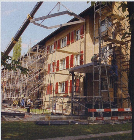
Die alten Balkone – sie waren in einer Nische angeordnet – wurden vollständig entfernt. Mit Hilfe eines Pneukrans waren die neuen Konstruktionen innert fünf Wochen montiert.
