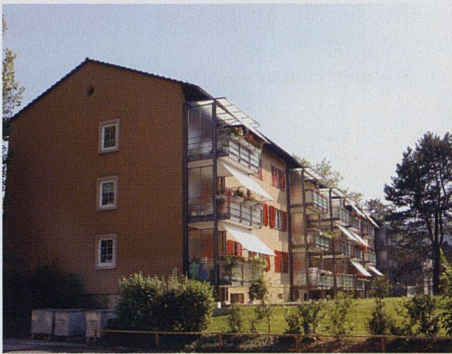
Blick von der Strassenseite: Die neuen Balkone und die in Weiss gehaltenen Storen sorgen auch optisch für eine Aufwertung.
