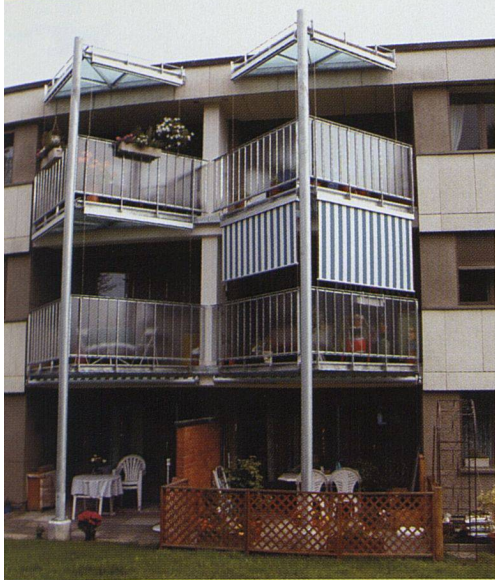
Für die 60er-Jahr-Siedlung der Baugenossenschaft Rotach in Rümlang erwiesen sich Balkonbauten in Dreieckform nicht nur ästhetisch als gute Lösung: Die Wohnungen gewannen gar an Tageslicht.
