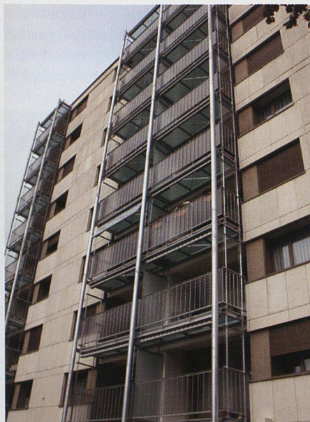
Beim Hochhaus verzichtete man auf die Dreieckform, da die Bewohner der Witterung zu sehr ausgesetzt gewesen wären.
