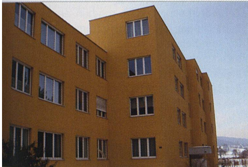
Blick auf die Eingangsseite: Neue Fenster sorgen für Schallschutz.
