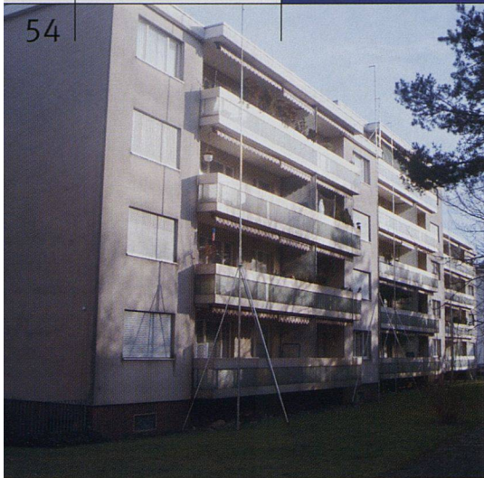
Die Bauten waren im Flügelbereich bisher nur viergeschossig (links, früherer Zustand). Dank der Aufstockung auf durchwegs fünf Stockwerke entstanden acht neue Wohnungen. Vergrösserte, verglaste Balkone sorgen für mehr Wohnkomfort.
