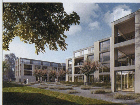
30 bis 40 preisgünstige Wohnungen will die Baugenossenschaft Zurlinden auf dem ehemaligen Fabrikareal in Zürich Wollishofen erstellen.
