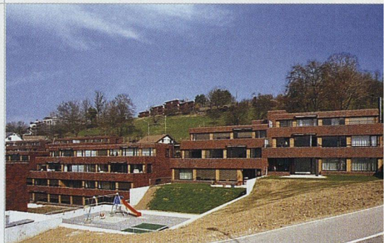
Um seinen Wohnungsbestand zu verjüngen, war das Unternehmen in den letzten Jahren auch selbst im Neubau aktiv. Ein Beispiel dafür ist diese vom Zürcher Architekten Jakob Steib entworfene Wohnsiedlung in Wettswil ZH.
