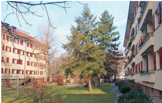
Ihre drei Liegenschaften hat die Wohngenossenschaft Holestrasse vor einigen Jahren umfassend saniert. Dank der zusätzlichen Wärmedämmung konnte der Energieverbrauch deutlich gesenkt werden.
