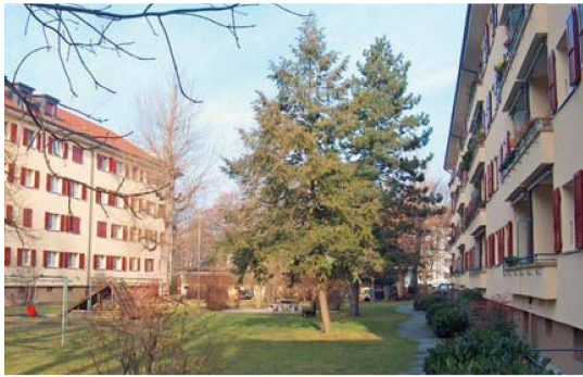
Ihre drei Liegenschaften hat die Wohngenossenschaft Holestrasse vor einigen Jahren umfassend saniert. Dank der zusätzlichen Wärmedämmung konnte der Energieverbrauch deutlich gesenkt werden.
