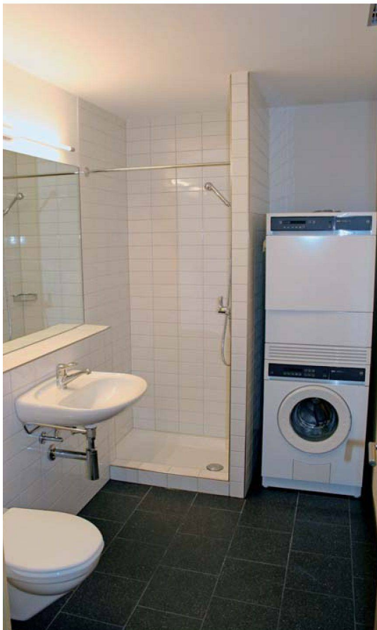
Der eigene Waschturm in der Wohnung gehört auch im genossenschaftlichen Wohnungsbau vielerorts bereits dazu: zum Beispiel bei der 2005 fertig gestellten Siedlung Am Tössufer der Heimstättengenossenschaft Winterthur.
