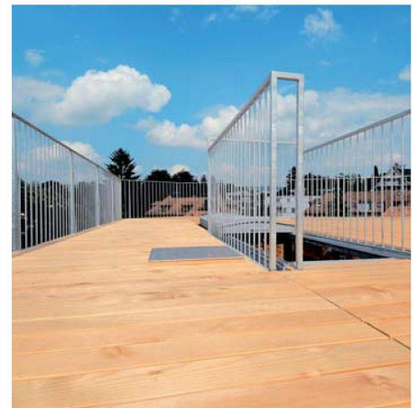
Die Ausstiegsluken mussten mit Schutzgeländern versehen werden.
