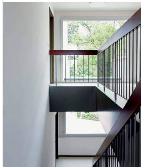
Eine Aufwertung erfuhren auch die Treppenhäuser mit den neuen Liften.
