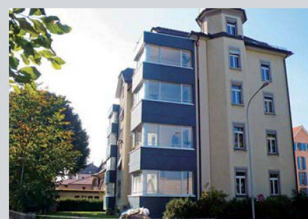
Im Jahr 2007 nahm die WBG 1904 eine Erneuerung ihrer Liegenschaft Goldbrunnenstrasse vor.
