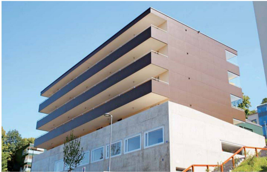
Die Linsebüelgut-Bauten thronen an einem Hang über dem Kompetenzzentrum Gesundheit und Alter.
