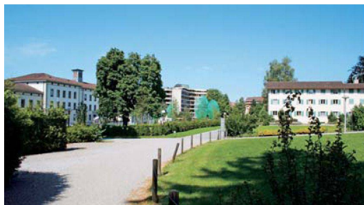
Der Flurgarten-Bau befindet sich auf dem parkartigen Gelände des Kompetenzzentrums Gesundheit und Alter, das auch ein Alters- und Pflegeheim sowie ein geriatrisches Zentrum umfasst.
