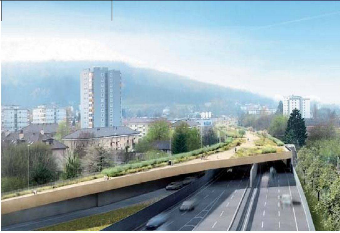
Visualisierung der geplanten Autobahneinhausung in Zürich Schwamendingen.
