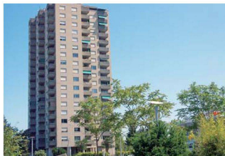
Die Gemeinnützige Baugenossenschaft Röntgenhof Zürich besitzt in Zürich und Umgebung Siedlungen aus verschiedenen Epochen.
