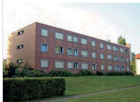
Früherer Zustand: Die schmucklosen Backsteinhäuser wurden zu rasch und billig gebaut.
