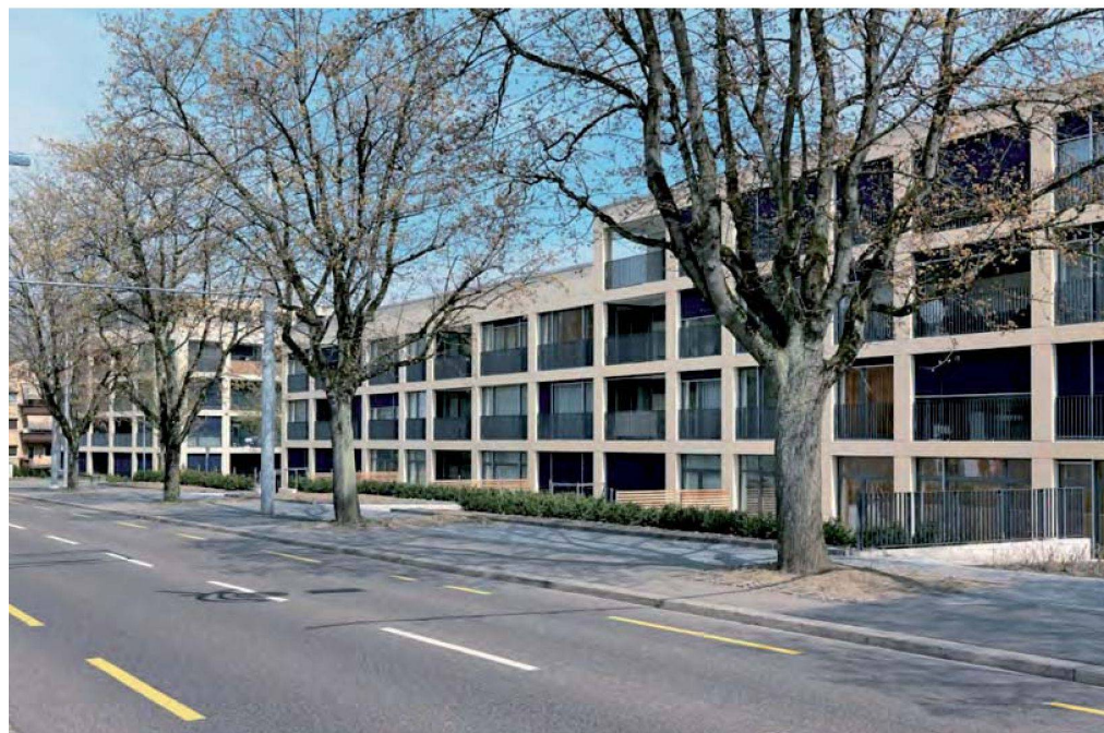
So präsentiert sich die Siedlung an der Wehntalerstrasse.
