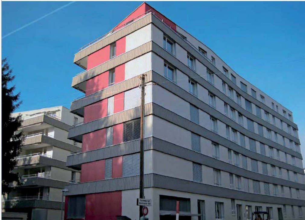
Der Querbau bildet einen Lärmriegel gegen die Farbhofstrasse und setzt im Quartier einen kräftigen roten Akzent. Ein leicht ausgestelltes Wellelternitband säumt die Fassade.
