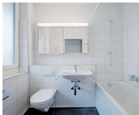
Blick in das neue Bad. Die Installationen sind in einem Vorwandsystem untergebracht.
