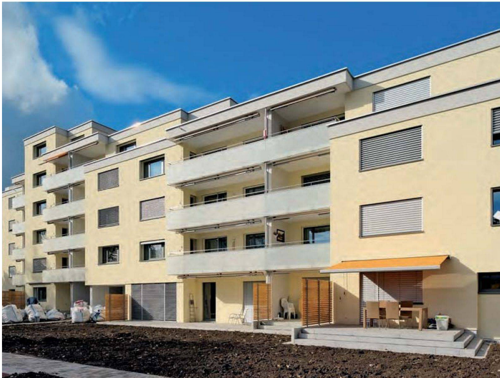
Mehrwert für die Mieterschaft: Sowohl auf der Strassen- als auch auf der Gartenseite (Bild) wurden die Balkone vergrössert.
