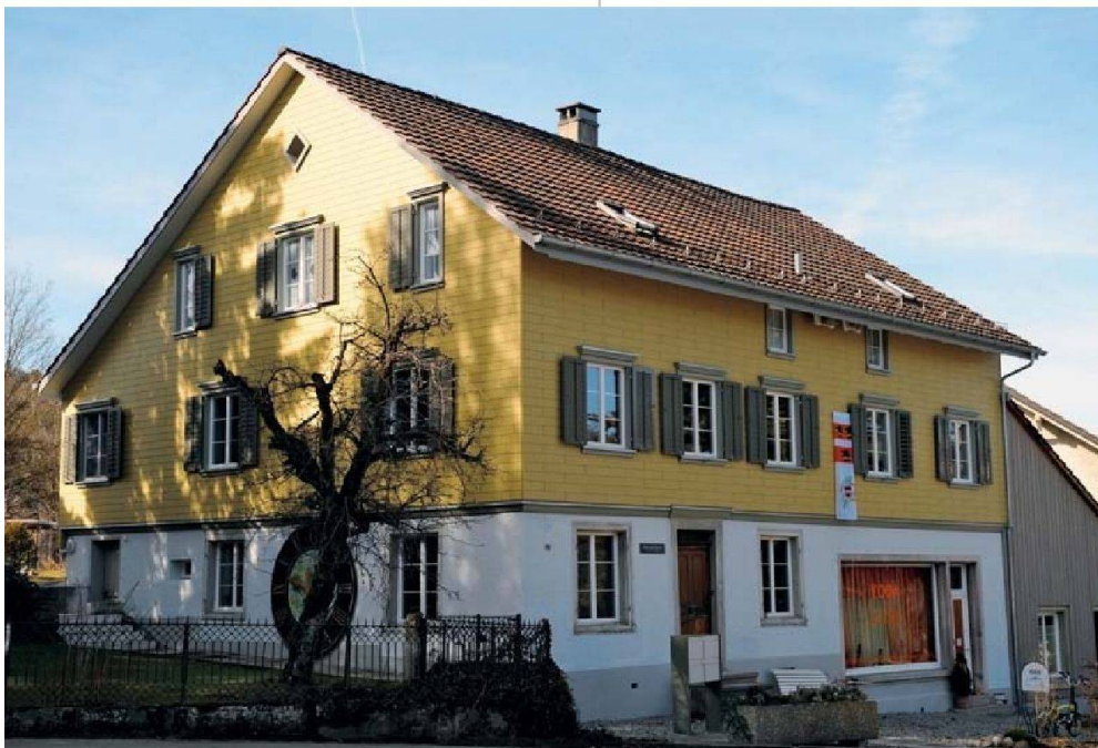
Das Haus zum Untertor war in einem schlechten Zustand, als die WAK es 2007 übernahm. Zur umfassenden Sanierung gehörte auch die Erneuerung der Fassade, die eine Aussenisolation erhielt.
