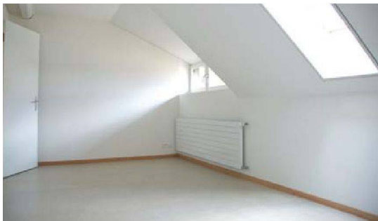
Einblick in eine Dachwohnung mit geschliffenem Betonboden.
