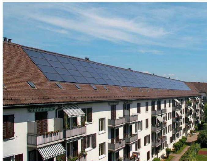
SOLTOP Solartechnik – Installateur: SADA – GBM-Genossenschaft + Erdgas Zürich
