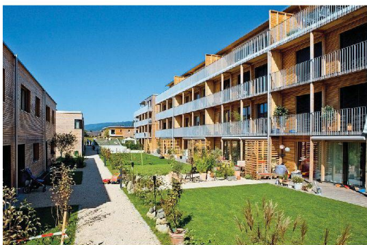
Nullenergiesiedlung Sunnywatt von kämpfen für architektur ag.
