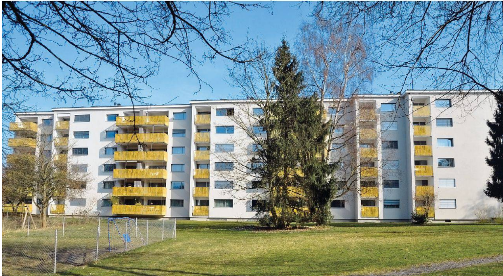
Das rundum erneuerte fünfstöckige Mehrfamilienhaus Heumatt 1 von der Gartenseite. Die Siedlung ist in einen grosszügigen Grünraum eingebettet.
