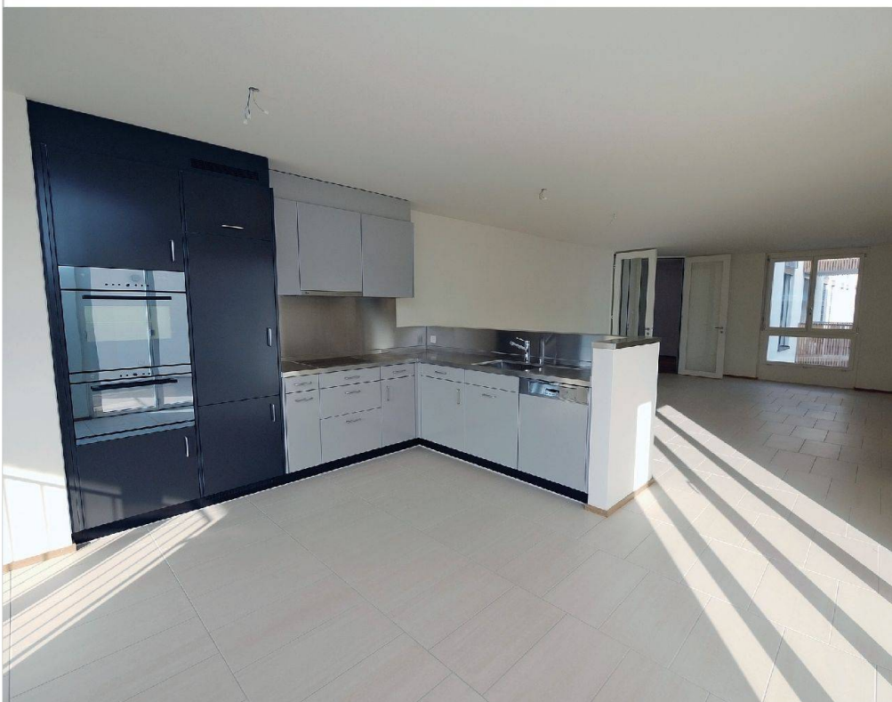
Die BGH entschied sich für Stahl-Winkelküchen und Keramikböden. Die Decken liess sie verputzen.
