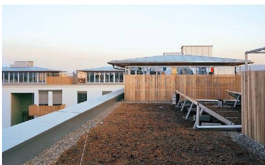
Die GBMZ hat die Waschsaloons in den Dachpavillons untergebracht.
