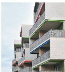
Titelbild: Neues Kleid für 1960er- Jahr-Überbauung: Siedlung SILU 3 in Bachenbülach.
