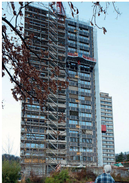
«Fassadenbänder» bestimmen das neue Erscheinungsbild.
