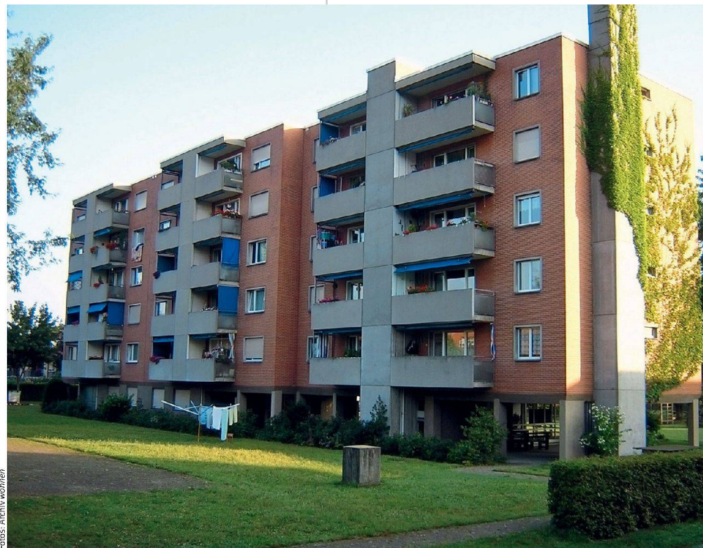
Bei einer Sanierung oft das Erste, das ansteht: kleine und schlecht isolierte Balkone. Im Bild die Siedlung Käppeli der BG zum Stab vor der Sanierung.
