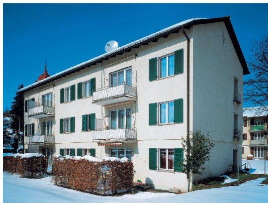
Neue Balkontürme mit Wintergärten lösen das Problem kleiner Balkone. Im Bild die Siedlung der BG Stern in St. Gallen vor und nach (grosses Bild links) der Sanierung.
