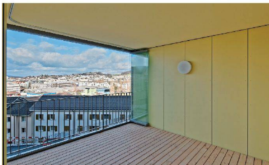
Dank schiebbarer Verglasung sind die Loggien einen grossen Teil des Jahres nutzbar.
