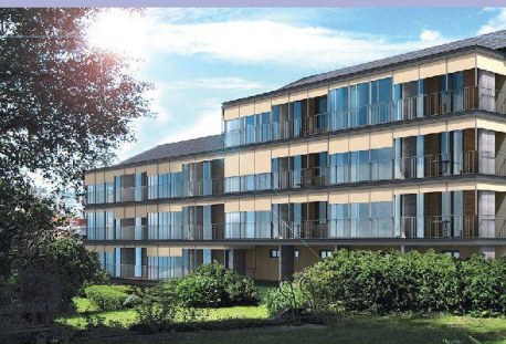
So werden sich die renovierten Häuser präsentieren. Dank einer Verandaschicht entsteht mehr Wohn- und Balkonraum.
