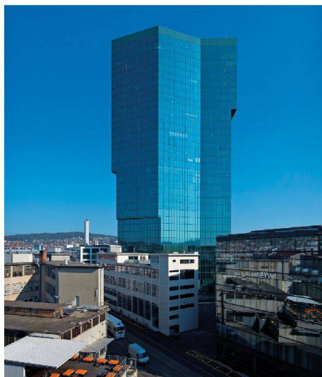
Hochhäuser sind aufwendig und teuer und tragen letztlich kaum zur Verdichtung bei. Trotzdem setzen insbesondere Unternehmen auf ihre grosse Symbolkraft (im Bild: Prime Tower in Zürich).
