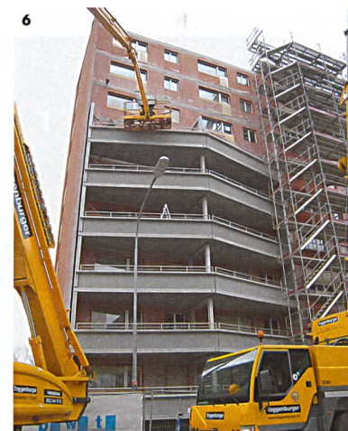
6 Bauzustand: Die alten Balkone sind vollständig entfernt, die neue Balkonschicht aus Fertigelementen wächst empor.
