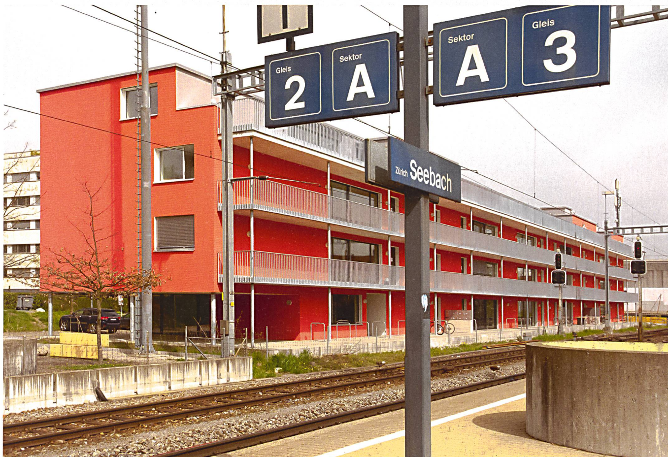
Den kecken Flachbau mit 103 Zimmern beim Bahnhof Seebach hat die WOKO in Rohbaumiete übernommen.
