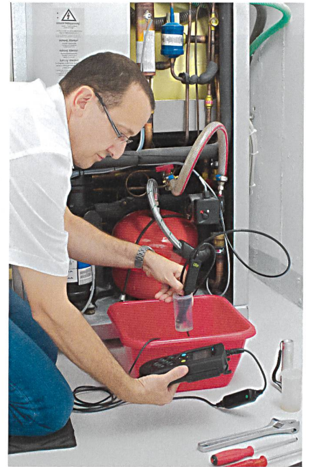
Sorgfältige Wasseranalyse vor der Sanierung
